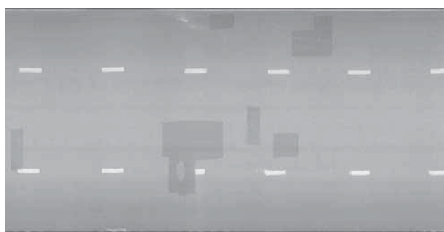
Рис. 3. Фрагмент дорожного покрытия. Получен с помощью системы видеокомпьютерного сканирования.
