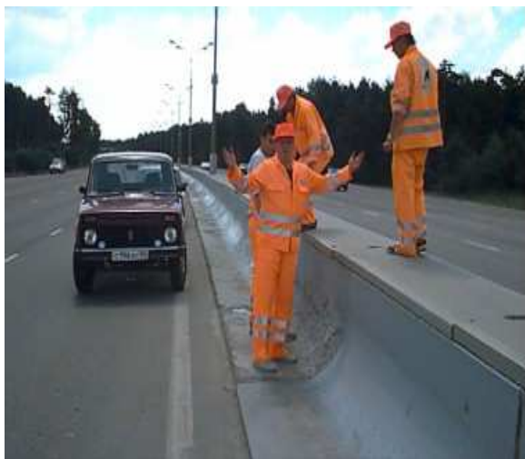
Рис. 3. Проведение обследования состояния железобетонного ограждения (МКАД)
